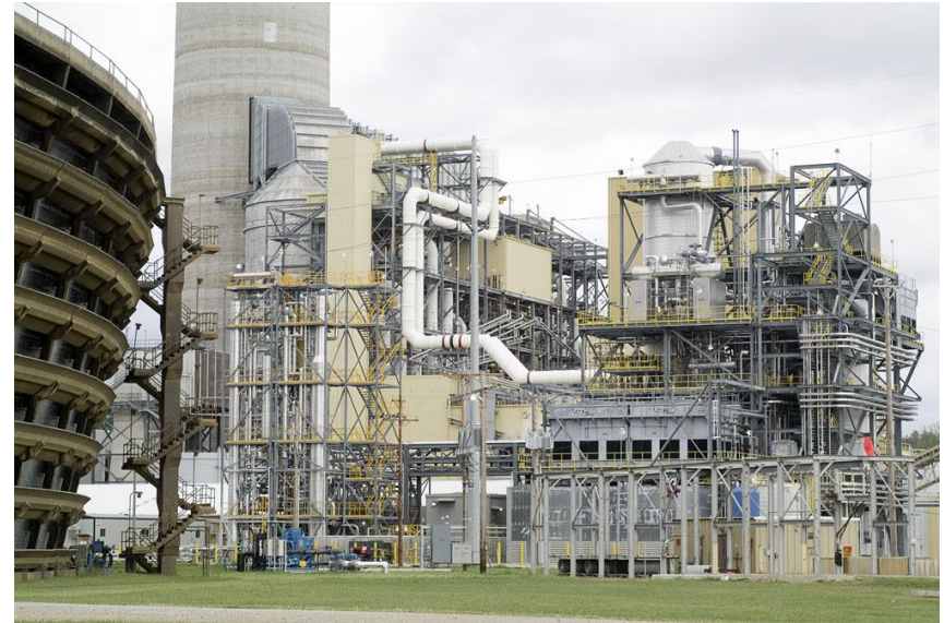
Voorbeeld van een CO 2 afvang bij een electriciteitscentrale (bron: jouleblog.files.wordpress.com )
