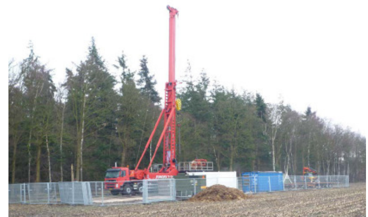
Boorinstallatie op truck (bron: www.haaksbergen.nl )
